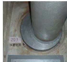
貫通部の止水処理(例)
