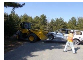
がれき撤去訓練
